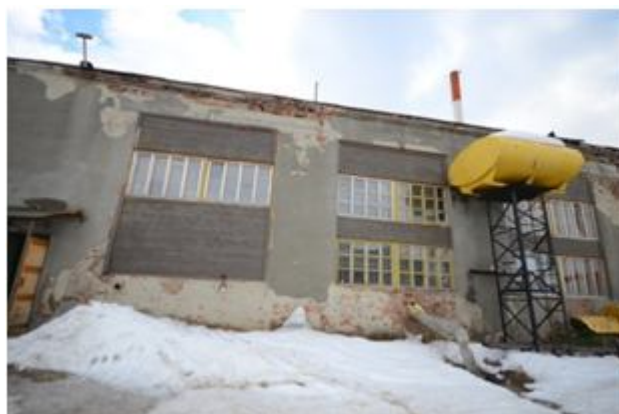
Рисунок 4.1 Здание котельной Аэропорт
